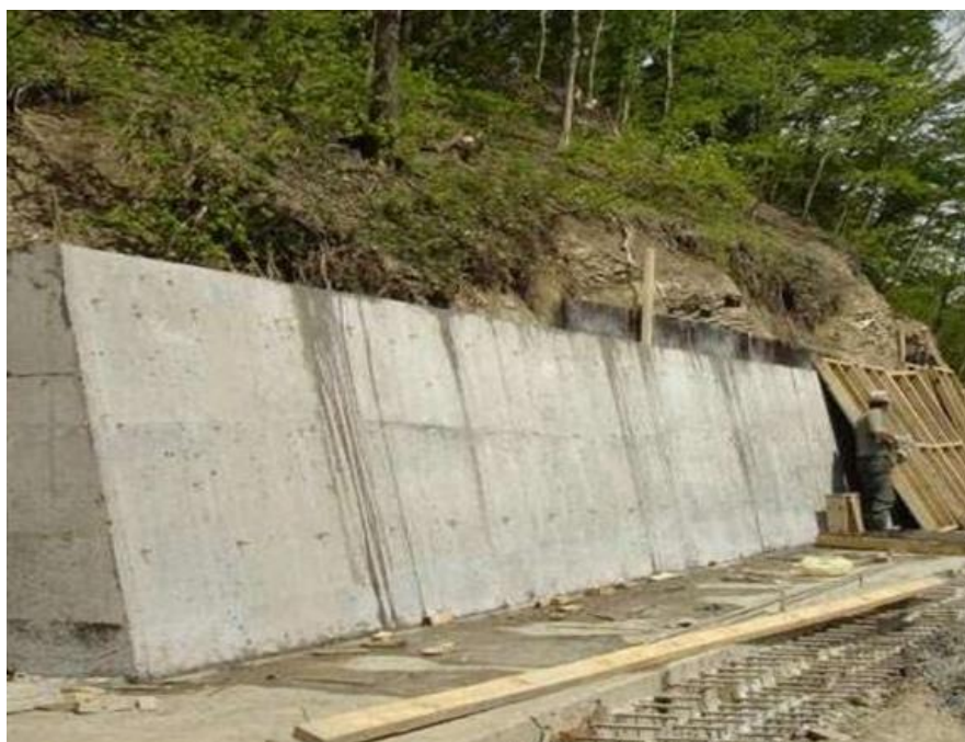
Рисунок 84 – Возведение подпорной стены
