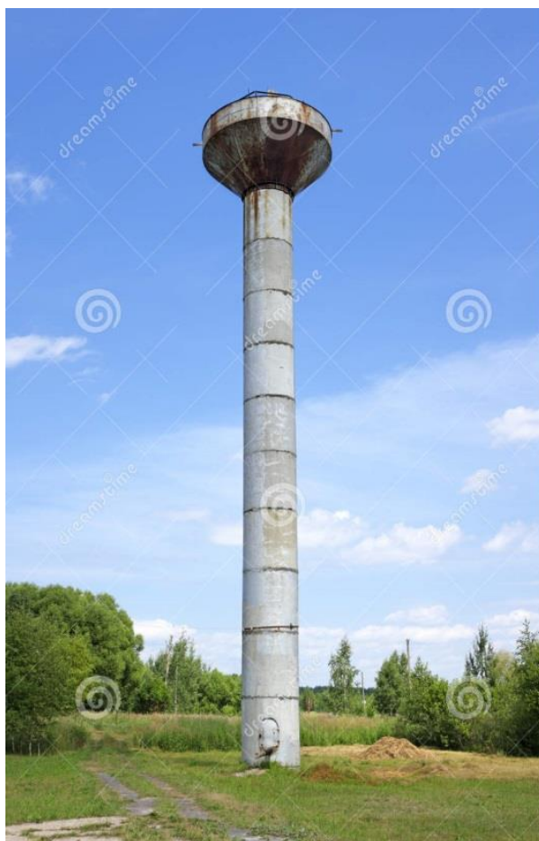
Рисунок 31 – Железобетонная водонапорная башня
