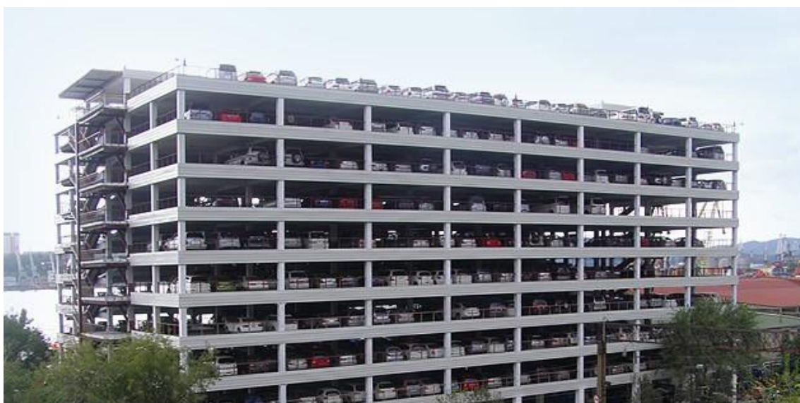
Рисунок 62 – Железобетонная многоэтажная автостоянка
