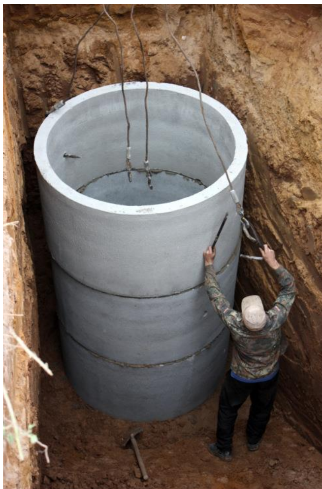
Рисунок 110 – Сборка обделки колодца
