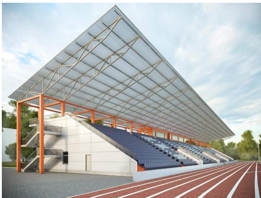
Рисунок 113 - Общий вид стадионного козырька консольного типа
