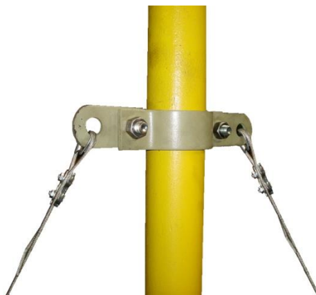
Рисунок 42 – Крепление оттяжки к стволу мачты
