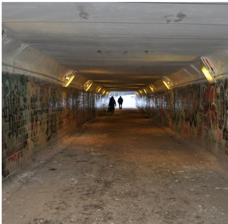
Рисунок 98 – Тоннель подземного пешеходного перехода
