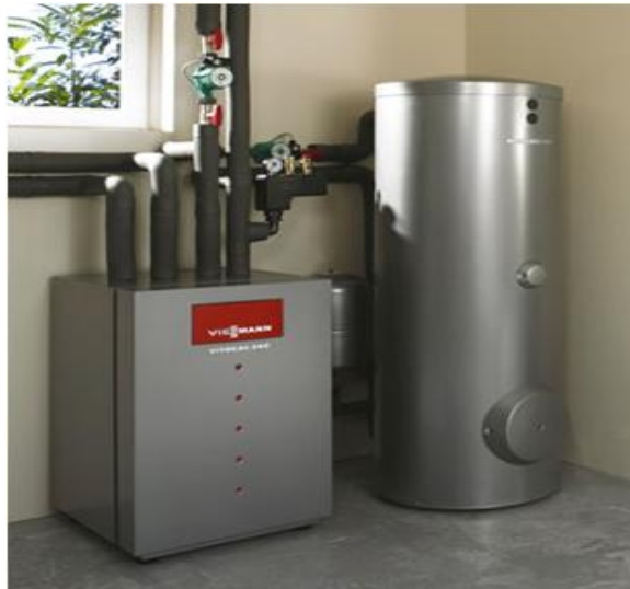
Рисунок 17 – Двухконтурный газовый котел с бойлером
