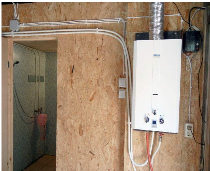
а) проточный водонагреватель
