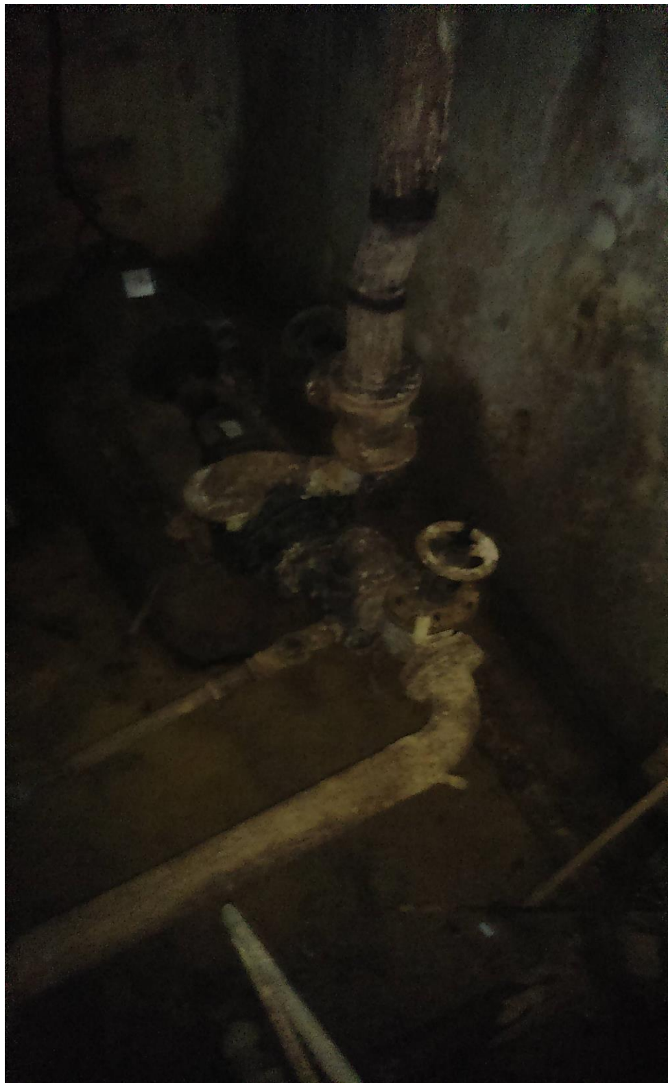
Рисунок 3.3. Подвальное помещение действующих очистных сооружений гальванического производства
