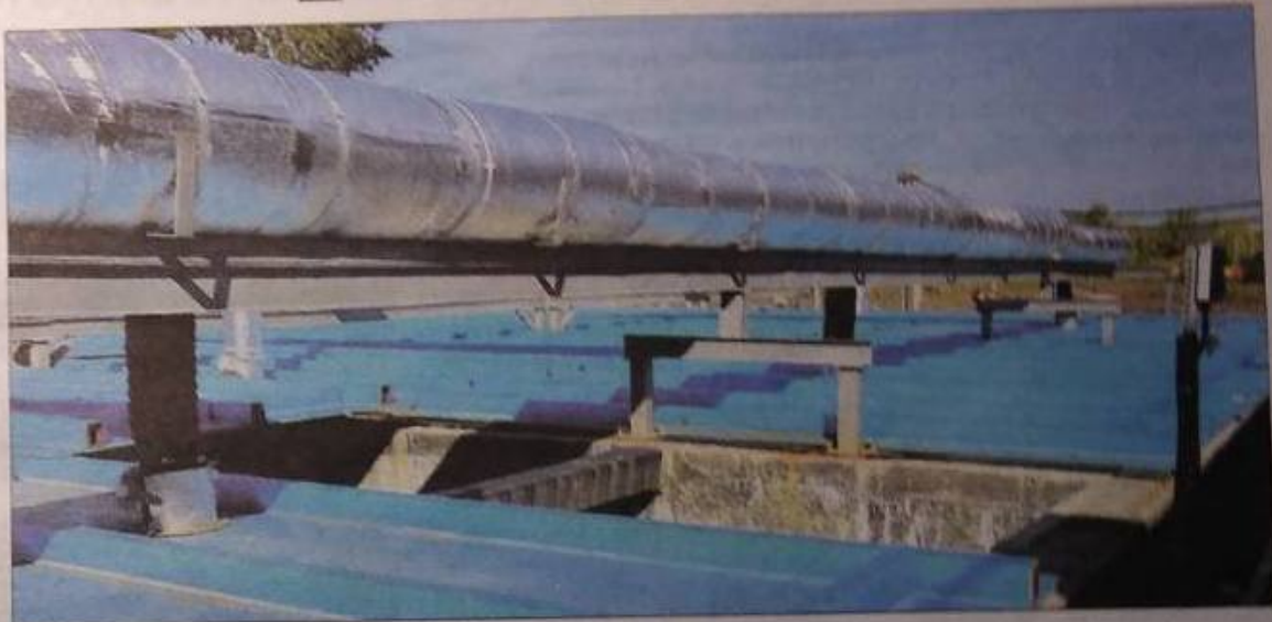
Вентиляция и полимерные перекрытия над приёмной камерой, куда поступают стоки с городских коллекторов, принесли долгожданный экологический эффект.
