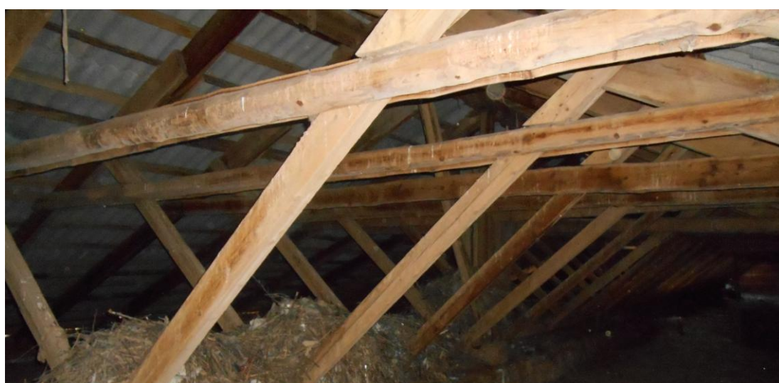
Рисунок 2.7 – Общий вид стропильной системы
