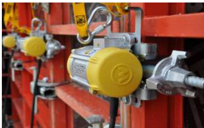
Рисунок 29 – Наружный вибратор
