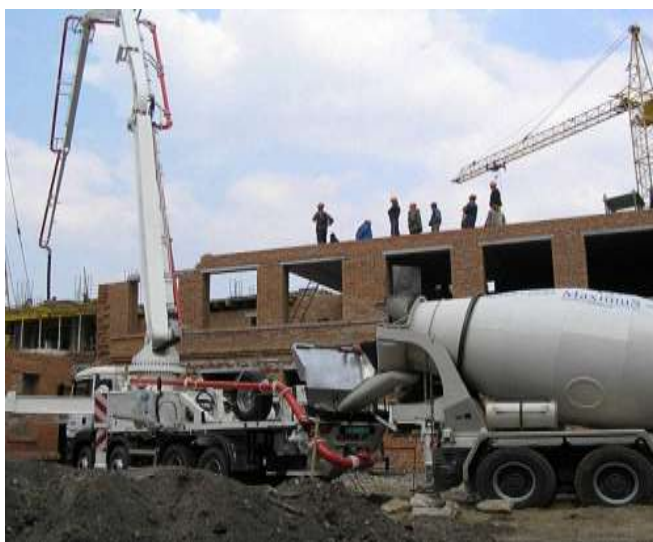
Рисунок 15 – Автобетононасос в работе с автобетоносмесителем.
