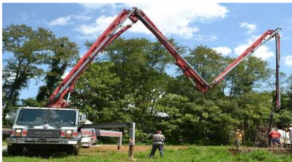
Рисунок 14– Автобетононасос в рабочем состоянии
