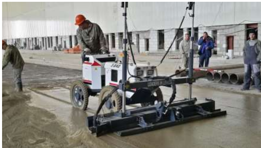
Рисунок 23 – Модель для укладки бетонных полов с лазерным управлением
