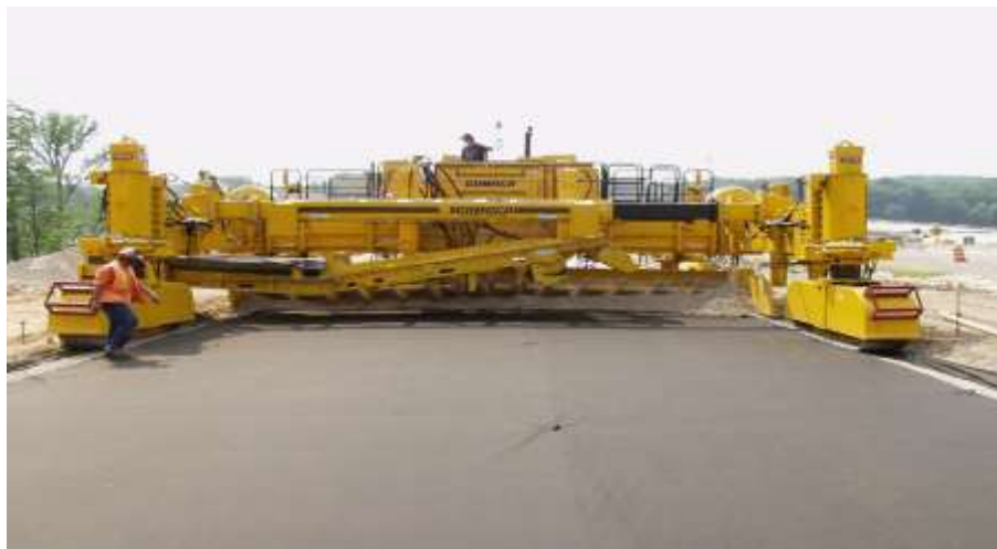
Рисунок 36 – Бетоноукладчик на гусеничном ходу
