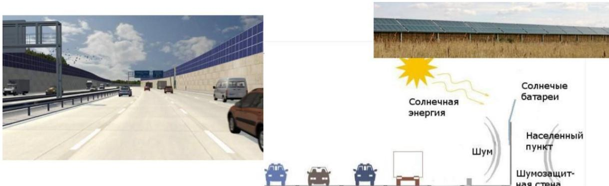
Рисунок 4.19 – Комбинированные акустические экраны (опыт Германии)
