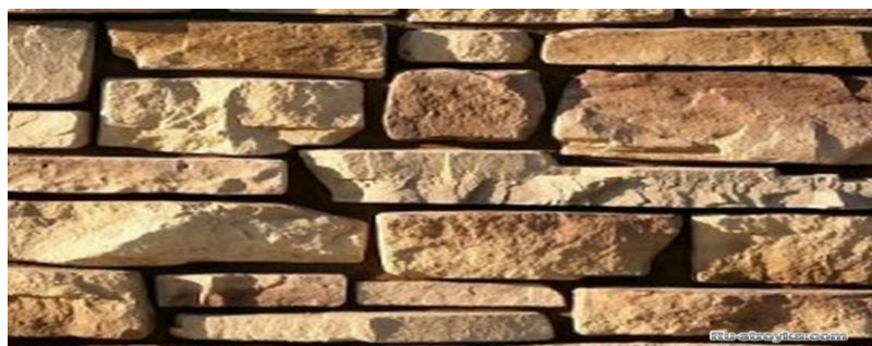
Рисунок 1.1 - Каменная кладка насухо, без вяжущего
