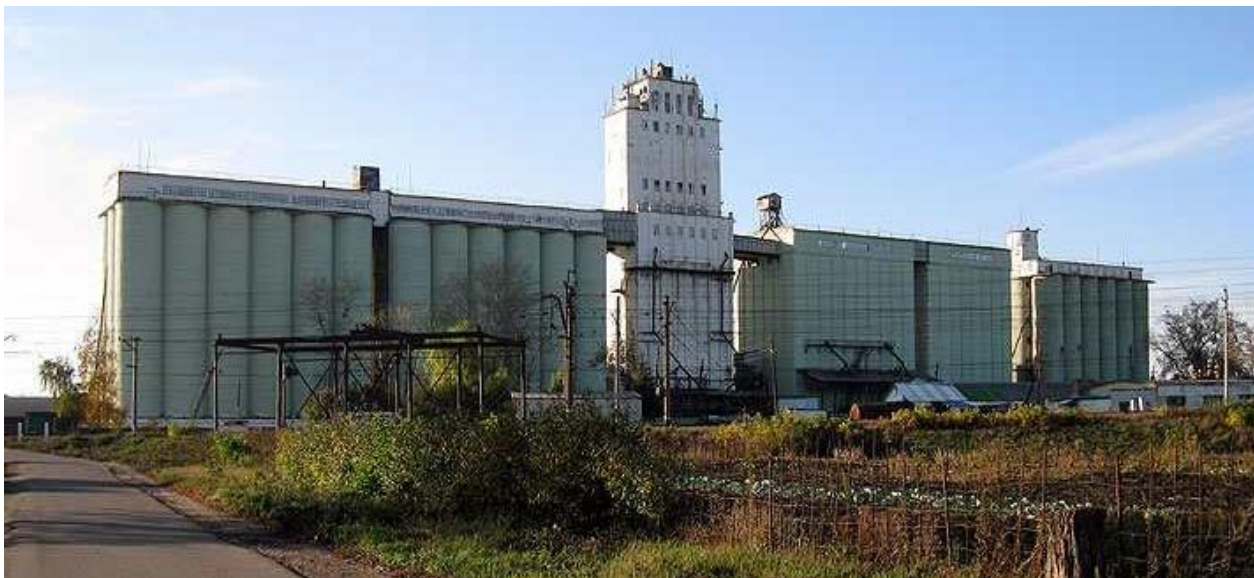
Рисунок 2.5 – Современный элеватор из железобетона
