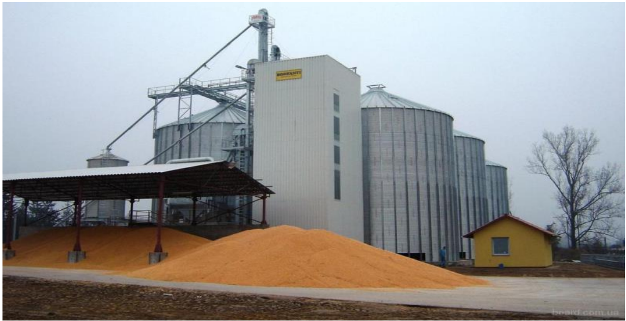
Рисунок 2.6 – Элеватор с silосами из металла для предприятий малой мощности
