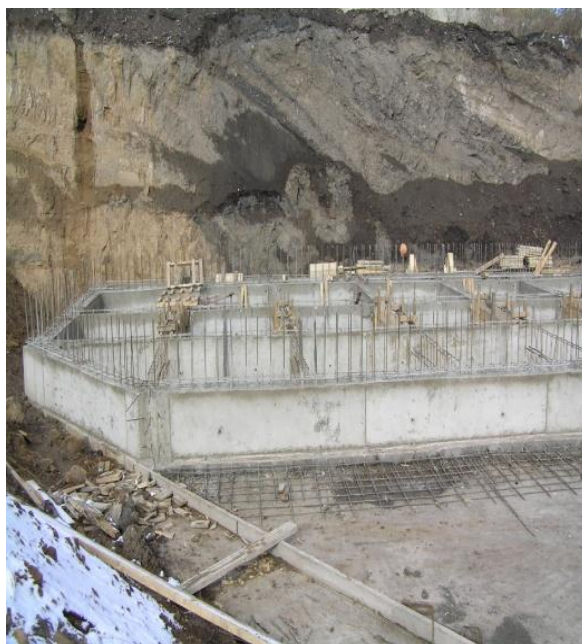
Рис. 13. Пространственная фундаментная платформа
