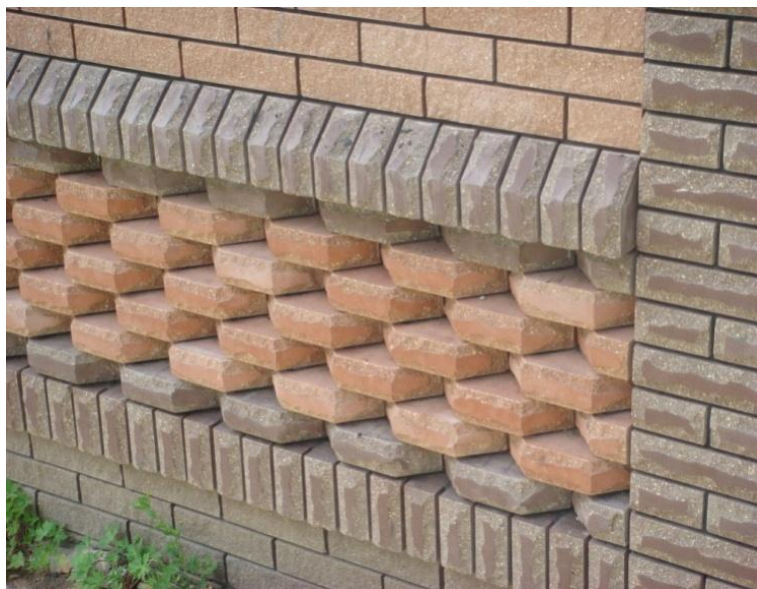
Рис. 2 – Кирпич как функциональный элемент стены жилого дома
