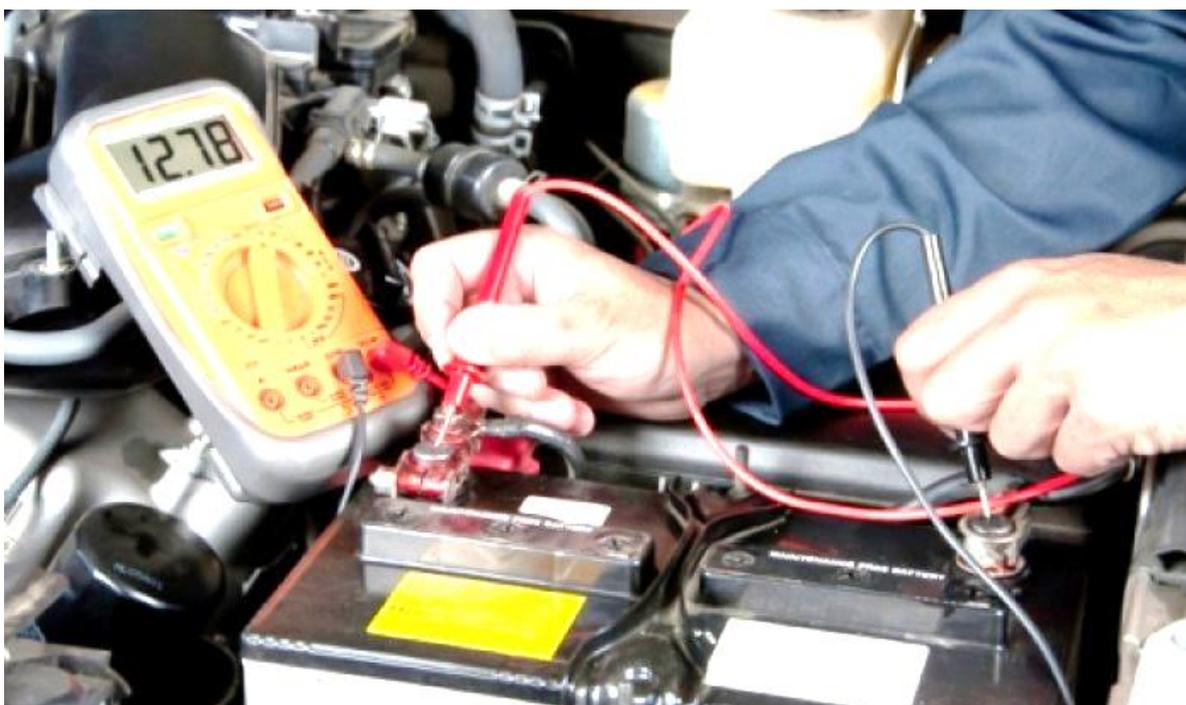
Рисунок 5.4 – Измерение ЭДС аккумуляторной батареи
