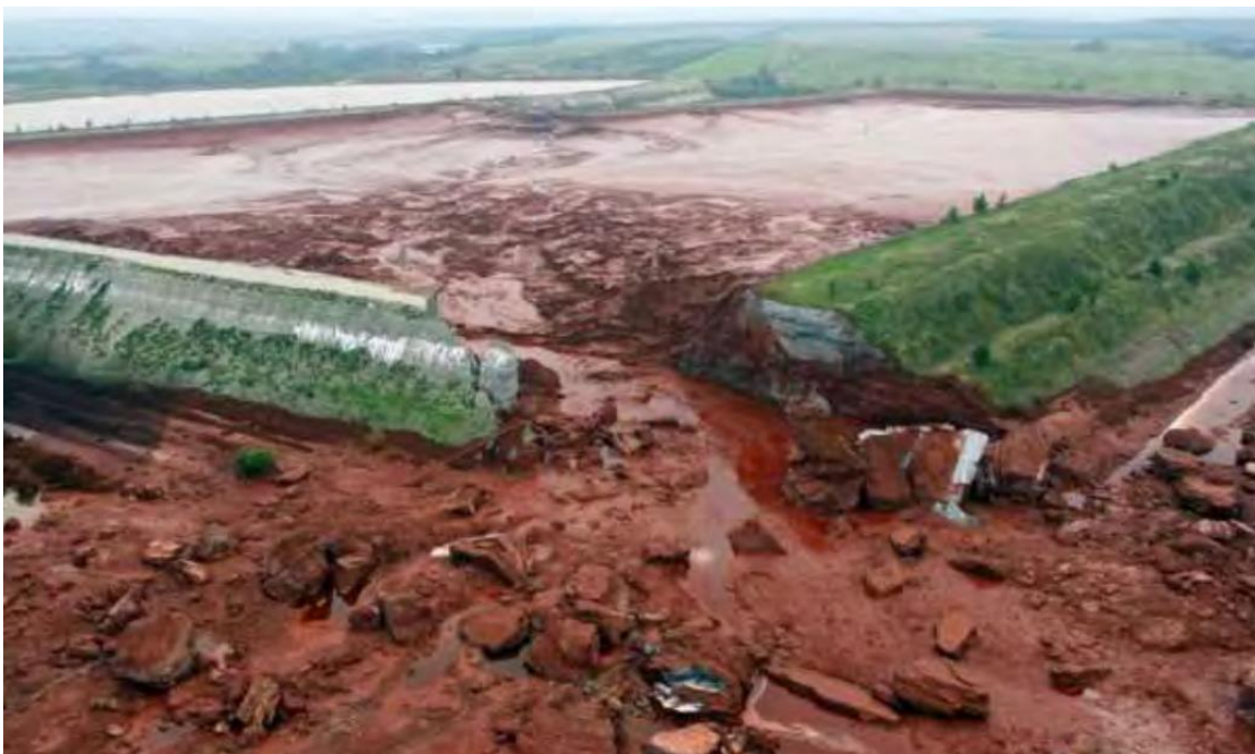
Рисунок 53 – Гидродинамическая авария на шламохранилище в Венгрии
