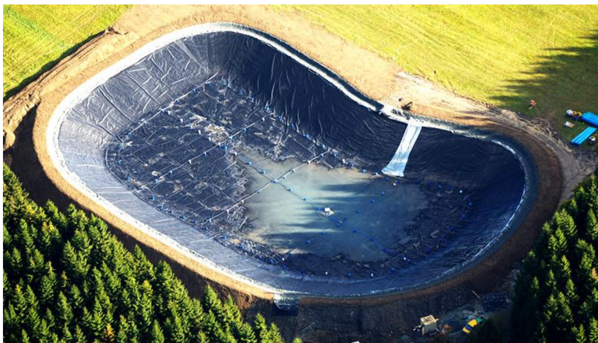
Рисунок 62 – Укладка материала «Карбофол»
