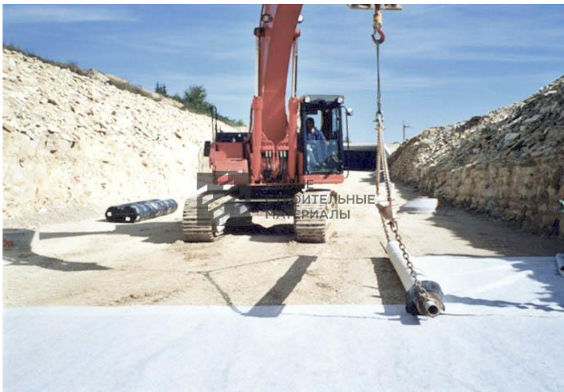
Рисунок 59 – Укладка бентофикса
