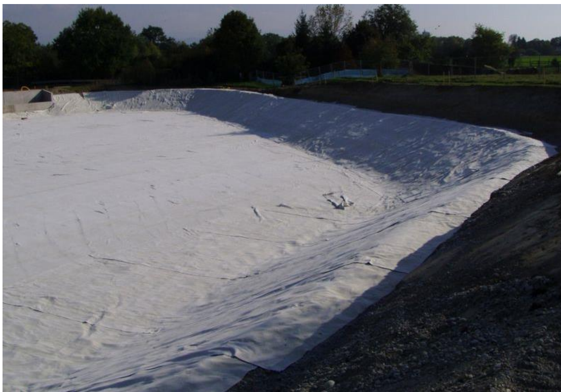
Рисунок 60 – Укладка бентофикса
