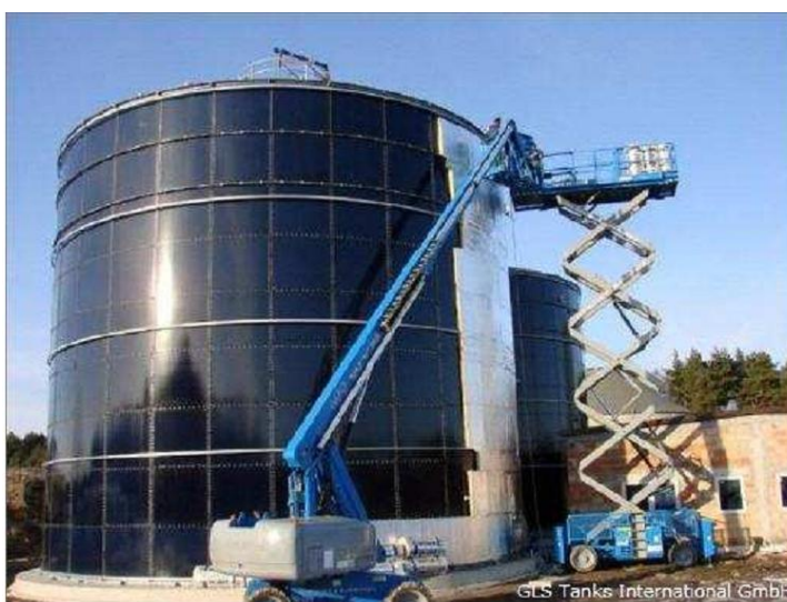
Рисунок 3.4 – Облицовка ферментера слоем стекловаты
