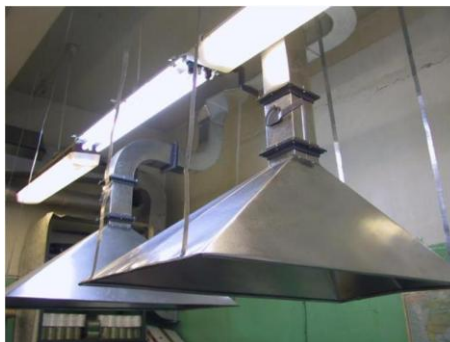
Рисунок 1- Пример вытяжной вентиляции
