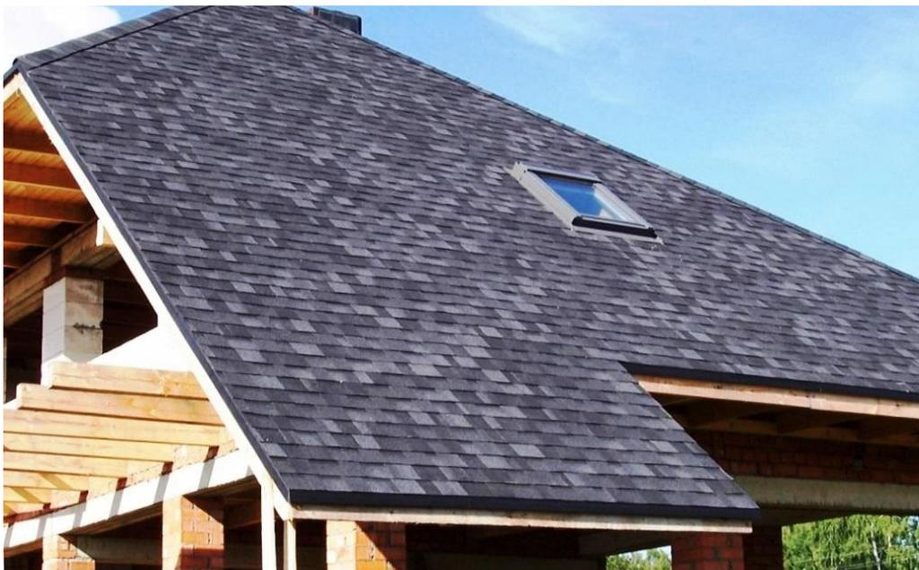
Рисунок 5.11 – Кровля из мягкой черепицы Шинглас
