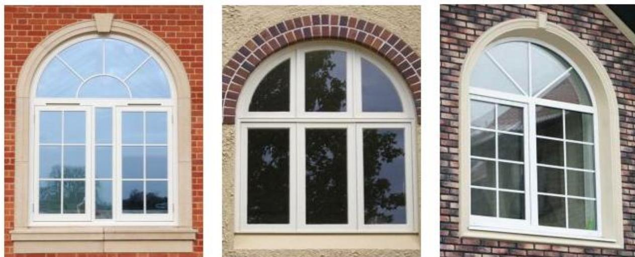
Рисунок 3.6 – Арочная перемычка (общий вид)
