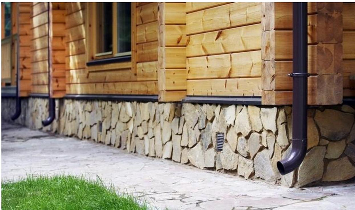
Рисунок 2.2 – Фрагмент решения цокольной части фундамента, общий вид
