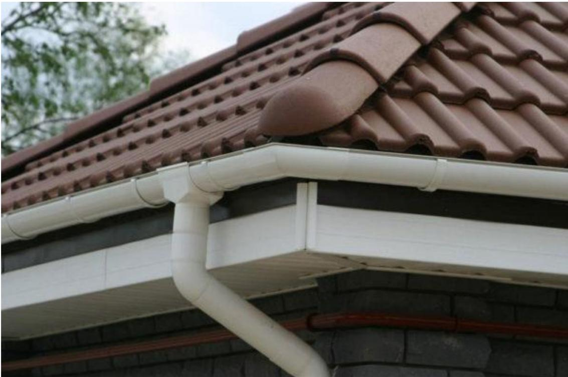
Рисунок 5.12 – Наружный организованный водоотвод (общий вид)
