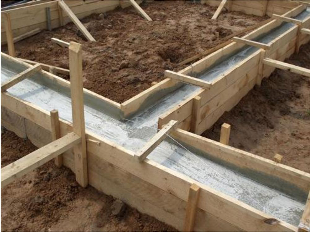
Рисунок 2.3 – Фрагмент монолитного бетонного фундамента, общий вид
