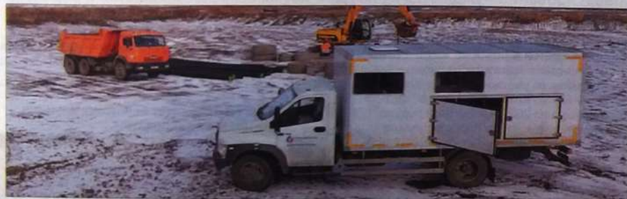
Очищенные и высушенные иловые карты будут использоваться как резервные площадки.
