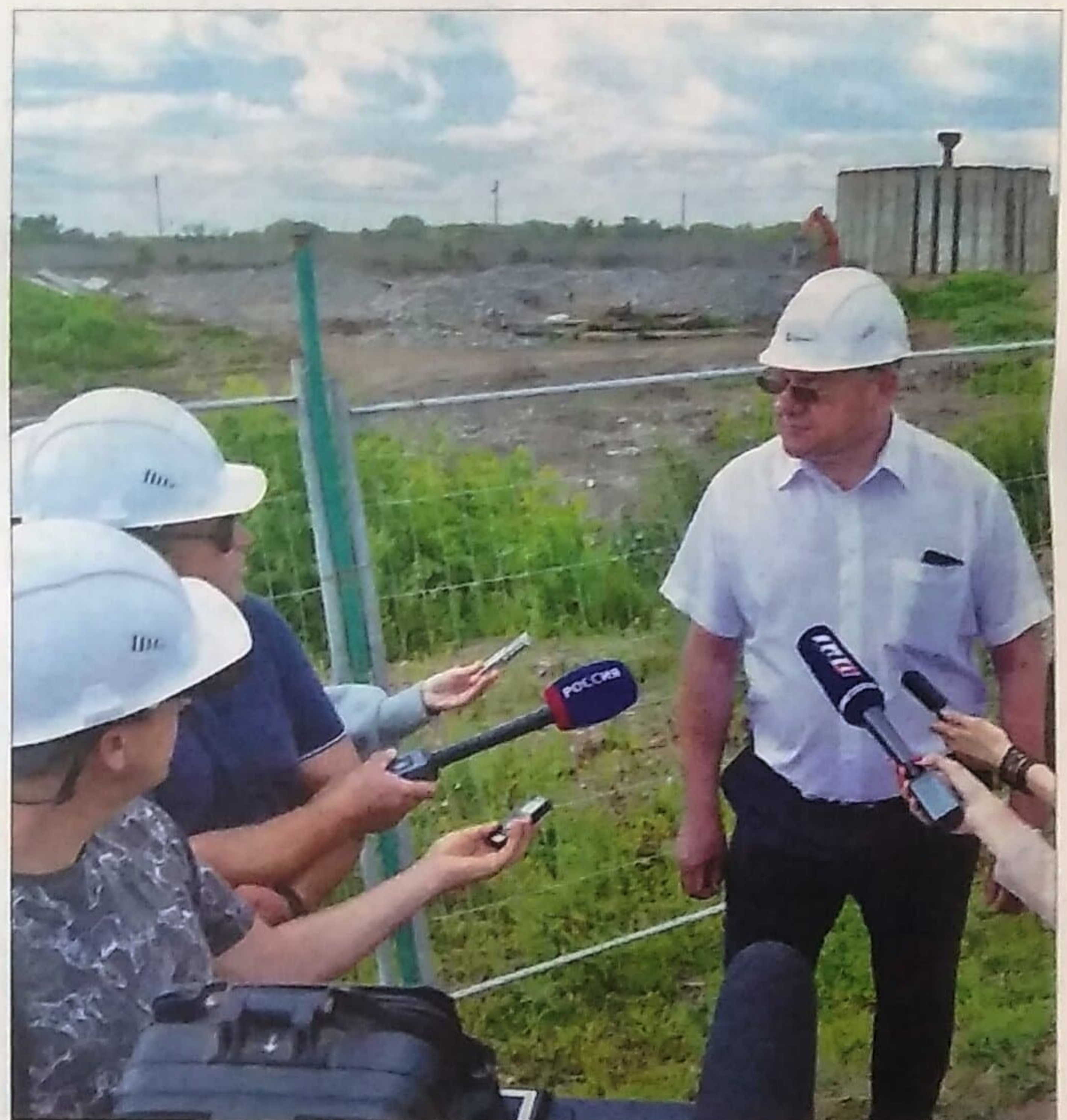
Главный инженер «Росводоканал Оренбург» Дмитрий Стрельцов показал площадку, которую готовят для строительства цеха мехобезвоживания.
