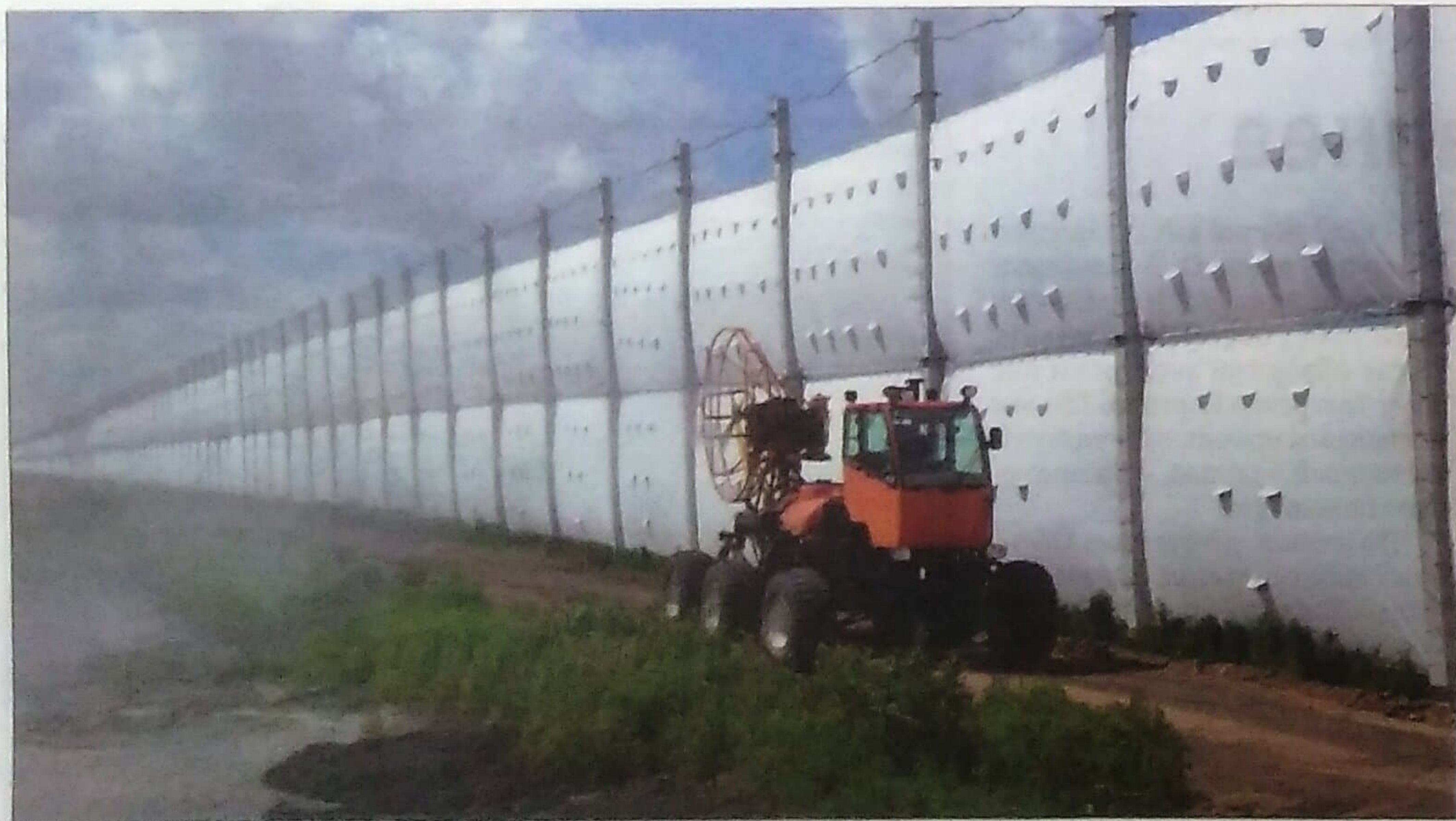
Мобильный распылитель дополнительно нагнетает реагенты на иловые карты для нейтрализации неприятного запаха от илового осадка.
