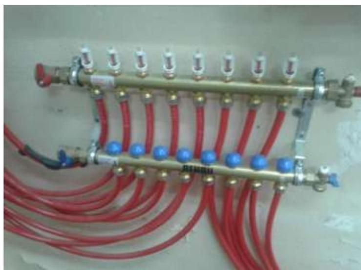
Рисунок 4 - Распределительный коллектор теплоносителя
