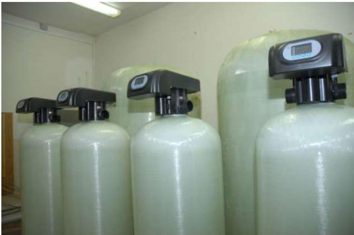
Рисунок 9 – Комплект напорных фильтров с управляющими клапанами
