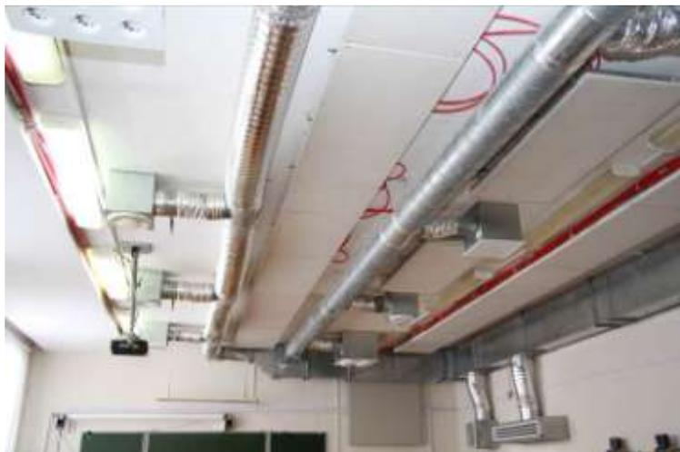
Рисунок 1 - Система панельного охлаждаемого потолка
