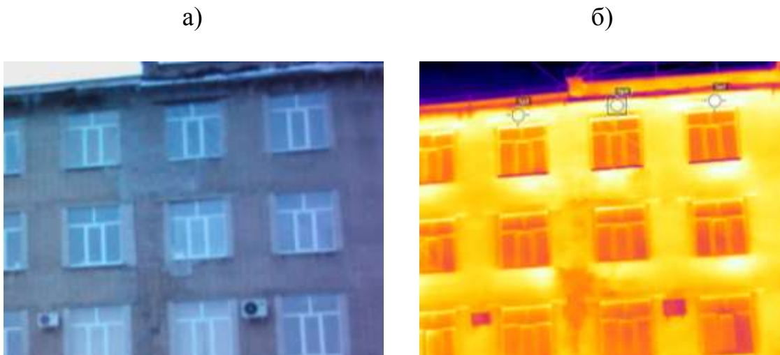
Рисунок 4 – Фотографическая съемка карнизного участка учебного корпуса № 3 (а) и термограмма участка (б)
