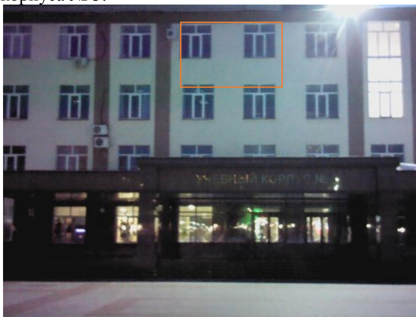
Рисунок 1 – Главный фасад Учебного корпуса № 3 ОГУ
