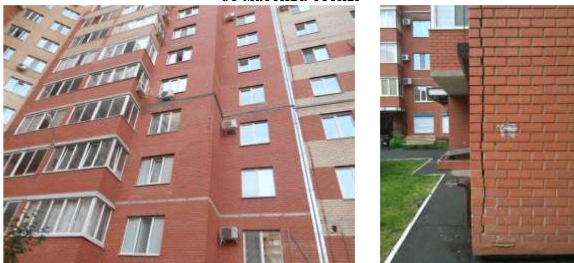
Рисунок 2 – Отслоения фасадного слоя от массива стены на примере жилого дома по ул. Джангильдина, 3 в г. Оренбург
