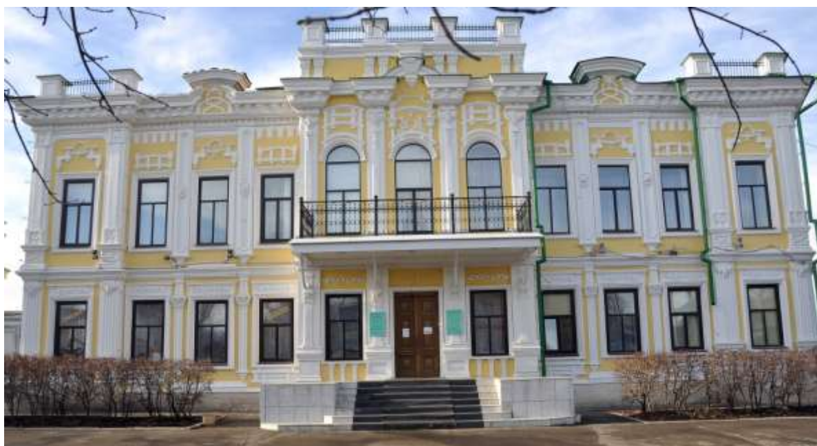
Рисунок 1. Главное здание усадьбы купца В.Е. Мякинкова (современное состояние)
