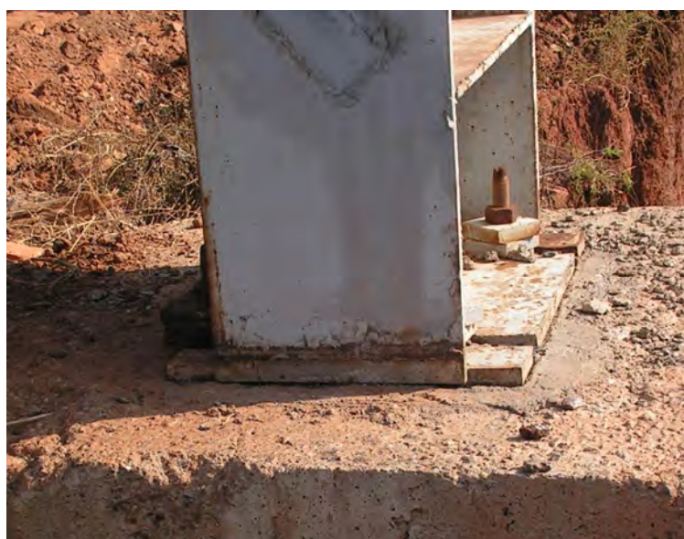
Рисунок 4 – Колонна каркаса, установленная «насухо» на фундамент
