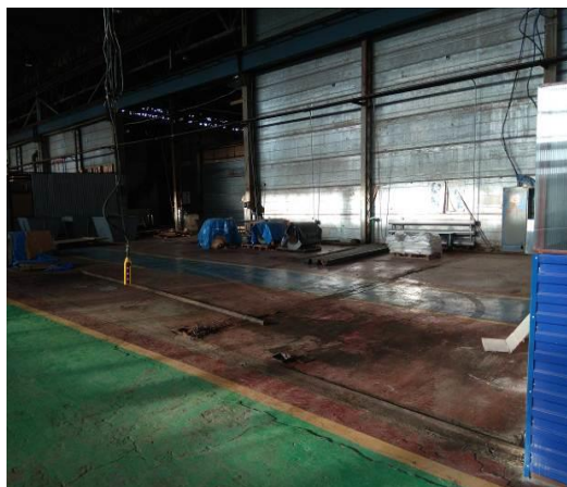
Рисунок 1 – Освобожденные площади после демонтажа участка пропитки трансформаторного оборудования
