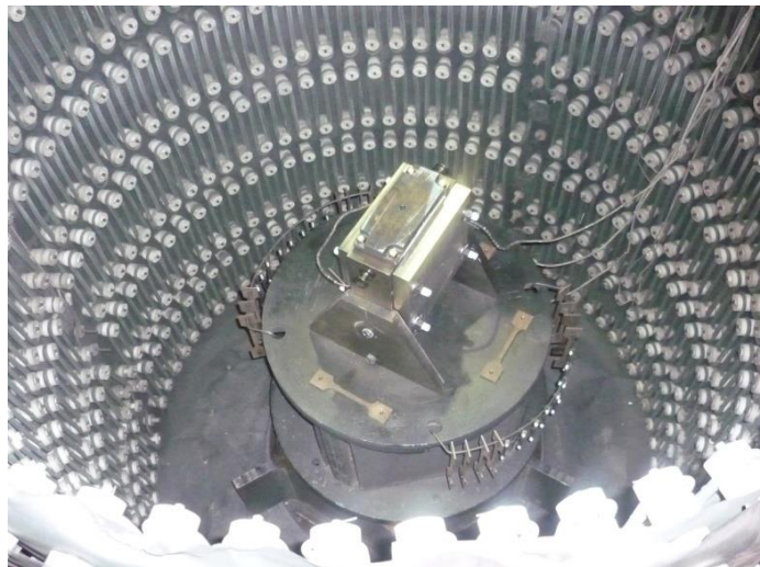
Рисунок 2 - Монтаж приспособления для сварки заготовок в камере установки
