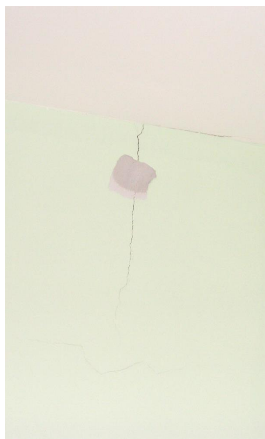
Рисунок 5.б – Аудитория 1609 ОГУ. Трещина в пилоне в осях 6-Г прошла по торцу балки покрытия. Гипсовый маяк в трещине не поврежден.
