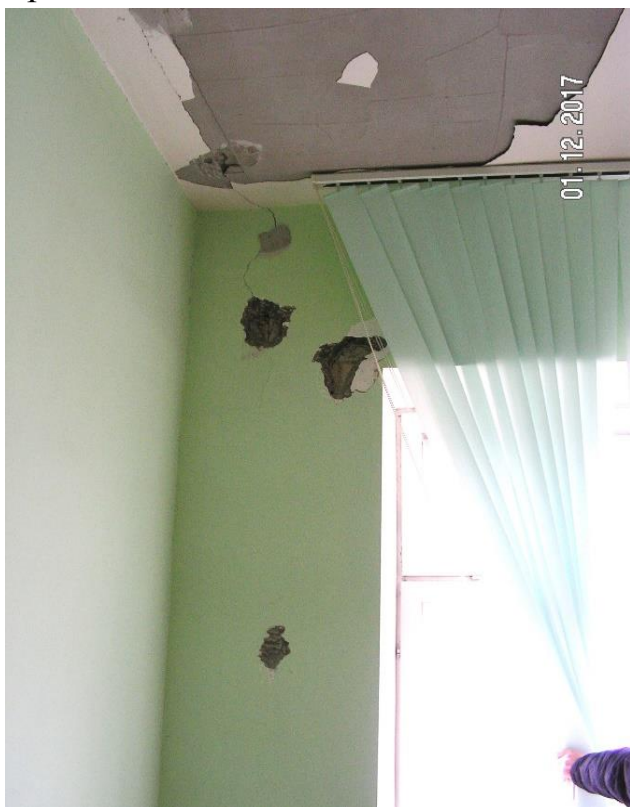
Рисунок 4 – Аудитория 1609 ОГУ. Простенок в осях 5-Д. Вскрытие участка кладки.
