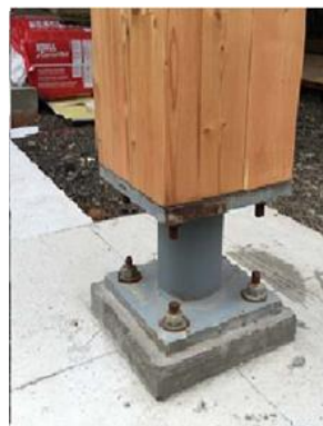
Рисунок 2 – Узел сопряжения колонны с фундаментом каркасного здания в Ванкувере.
