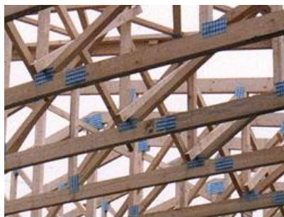
а) зубчатая пластина; б) ферма на МЗП
