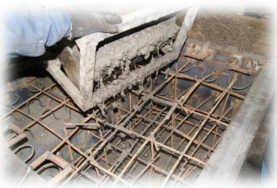
Рисунок 3 - Процесс изготовления станины из железобетона
