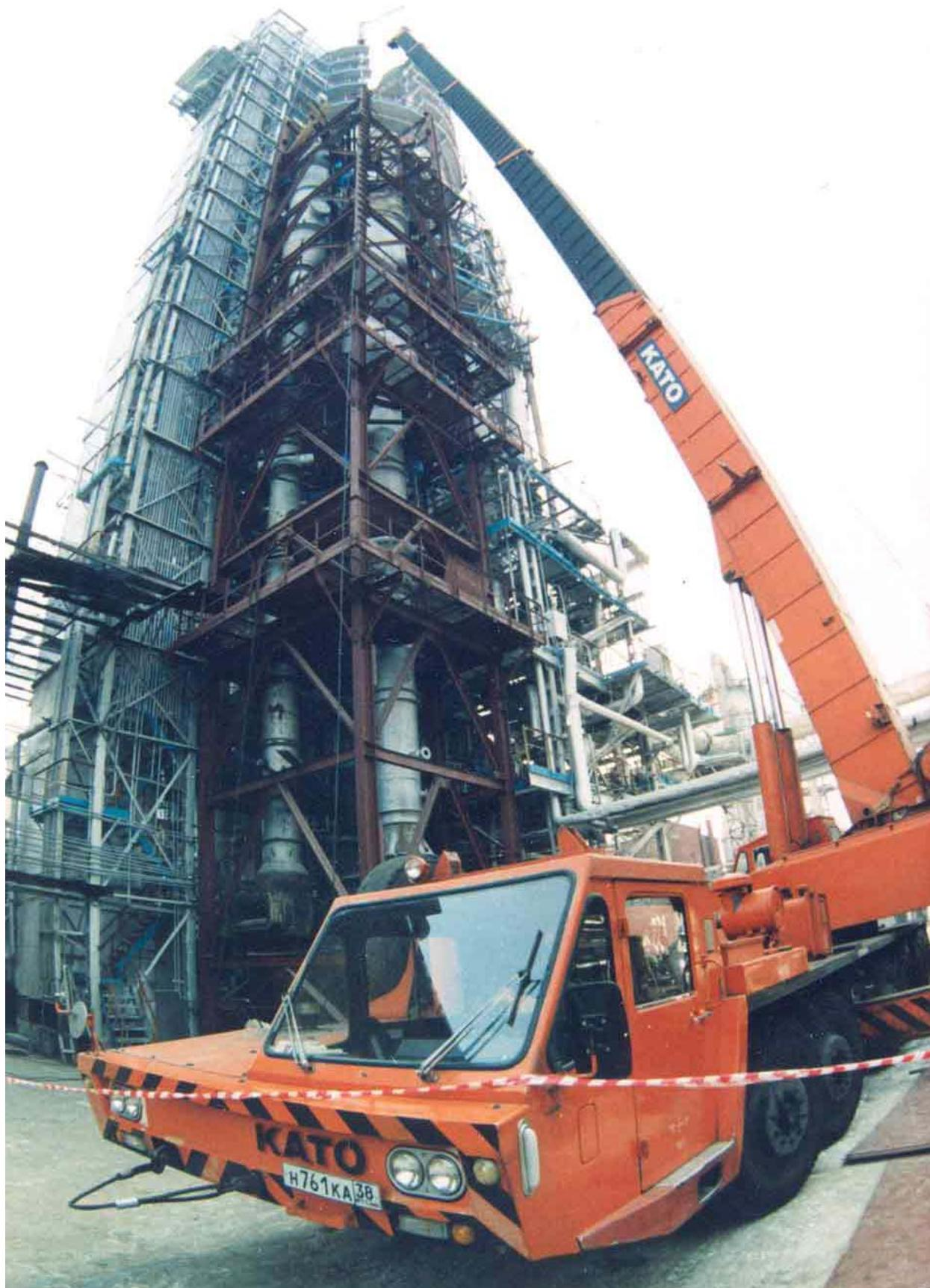
Рисунок 5 – Монтаж колоны с помощью автомобильного крана
