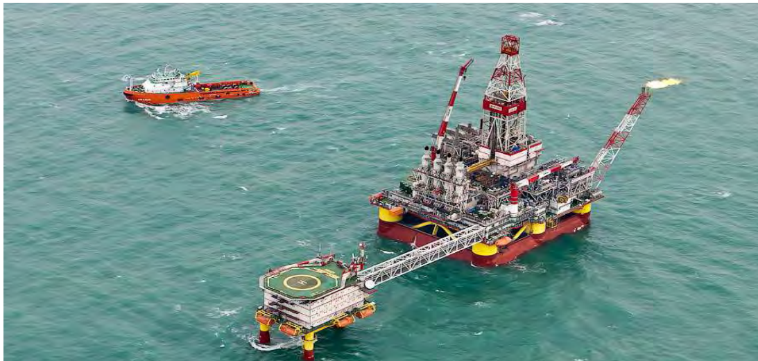
Рисунок 2 – Морская стационарная платформа с вертолетной площадкой
