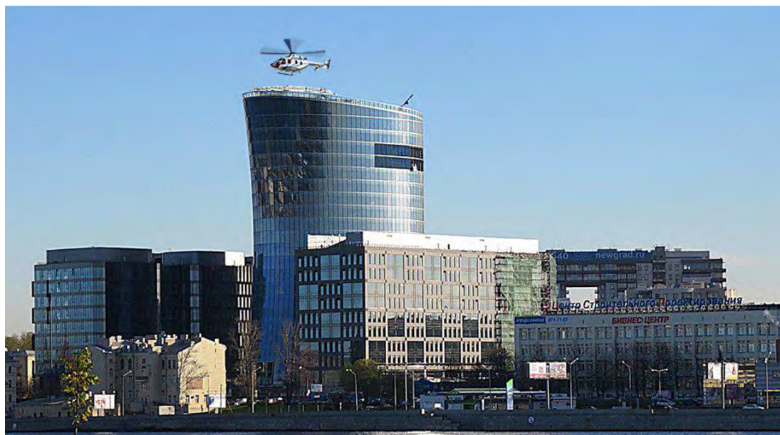
Рисунок 1 – Вертолетная площадка на кровле высотного здания
