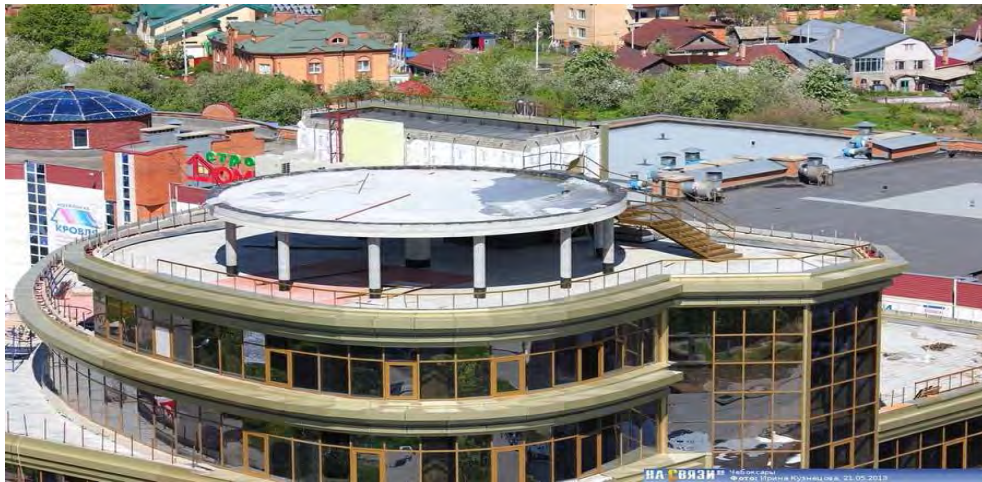
Рисунок 3 – Возведение вертолетной площадки с использованием трубобетонных конструкций
