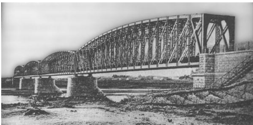
Железнодорожный мост через реку Урал
